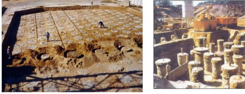
Görsel 3. Jet grout yöntemi ile zemin güçlendirilmesi
