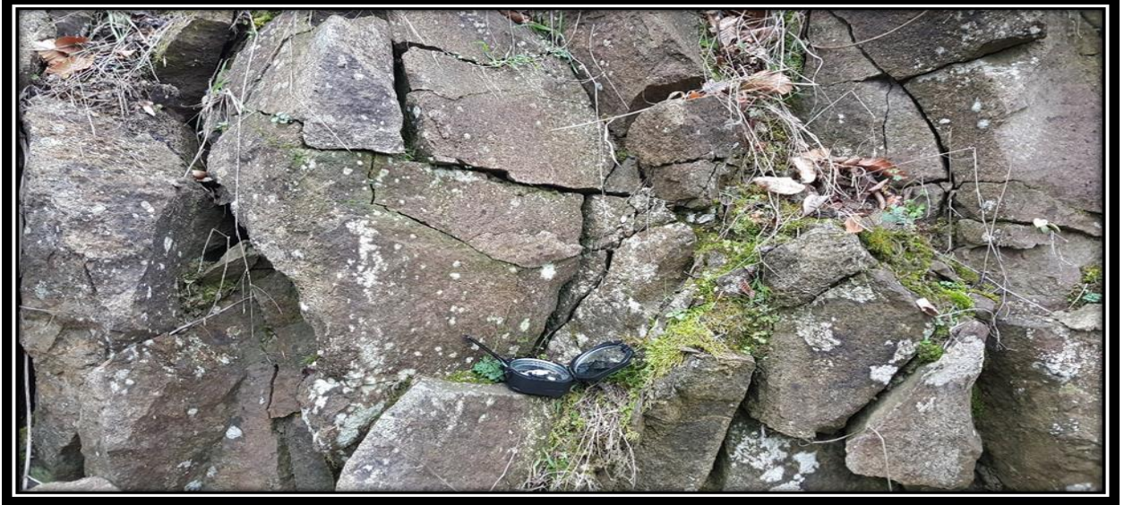
Şekil 1: Santral Sahasında Ölçülen Eklem Durumlarının Görünümleri
