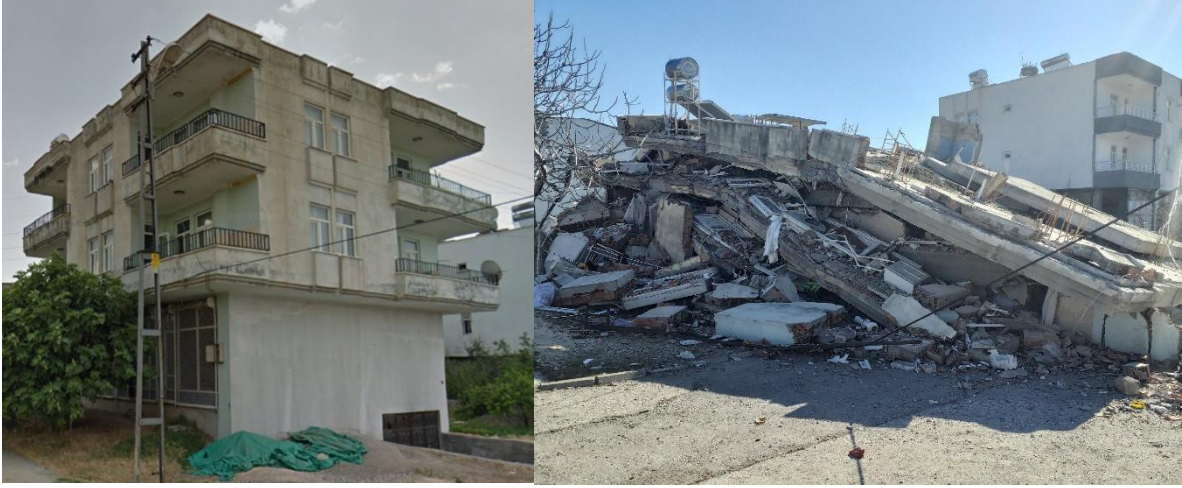
Görsel 1. 2000 yılı öncesi inşa edilmiş ve toptan göçmeye maruz kalmış BA yapı örneği
