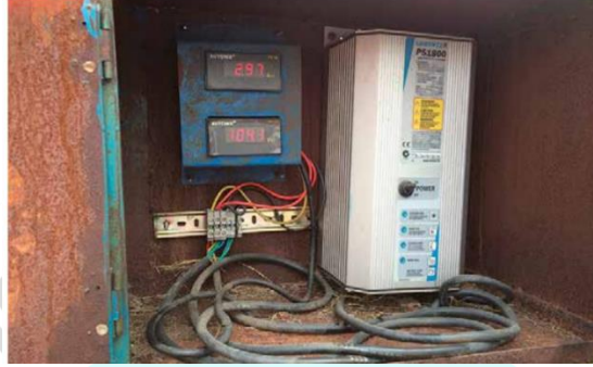
Görsel 7. Aşınmış Denetleyici Muhafazası
