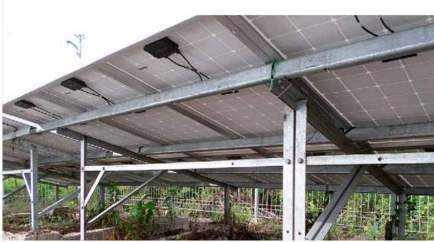
Görsel 1. Dış Mekan Uygulamaları İçin PV Modül Ve Dizi Kabloları
