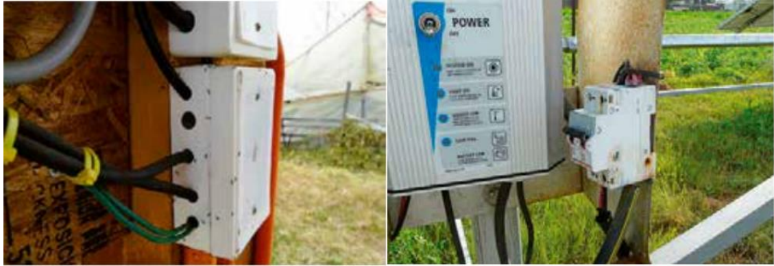
Görsel 5. Sol: Karıncaların Yaşadığı Bağlantı Kutusu, Sağ: Su Geçirmez Olmayan Devre Kesici
